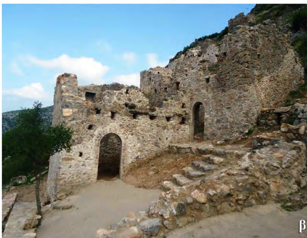
Εικ. 3. Κάστρο Γερακίου, οικισμός. Κτήριο 2, άποψη από ΝΔ. α. Πριν τις εργασίες συντήρησης-στερέωσης (Αρχείο ΕΦ.Α.ΛΑΚ., Θ. Ρήγου, 2011). β. Μετά τις εργασίες (Αρχείο ΕΦ.Α.ΛΑΚ., Α. Μαρδά-Στυψιανού, 2015).
