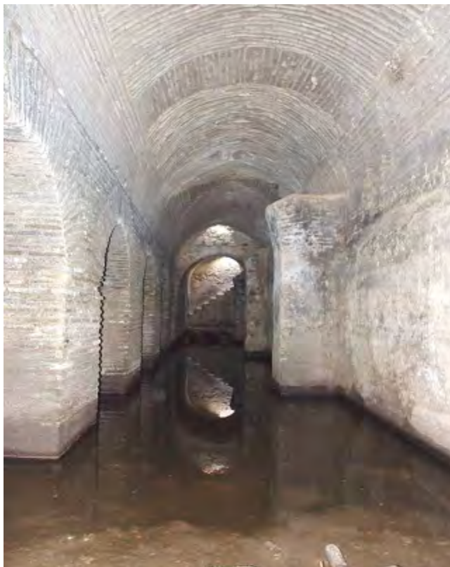
Εικ. 2. Εσωτερική άποψη του βόρειου χώρου της βυζαντινής κινστέρνας, Γ' περίβολος κάστρου Ακροκορίνθου, Αρχαία Κόρινθος (Αρχείο ΕΦ.Α.ΚΟΡ.).
