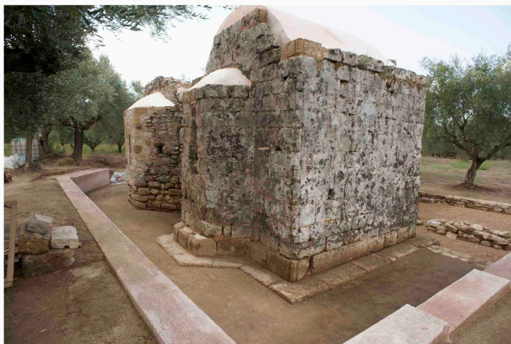
Εικ. 9. Στερέωση-ανάδειξη ναού Αγίου Νικολάου Αίπειας (φωτ. ΕΦ.Α.ΜΕΣ.).
