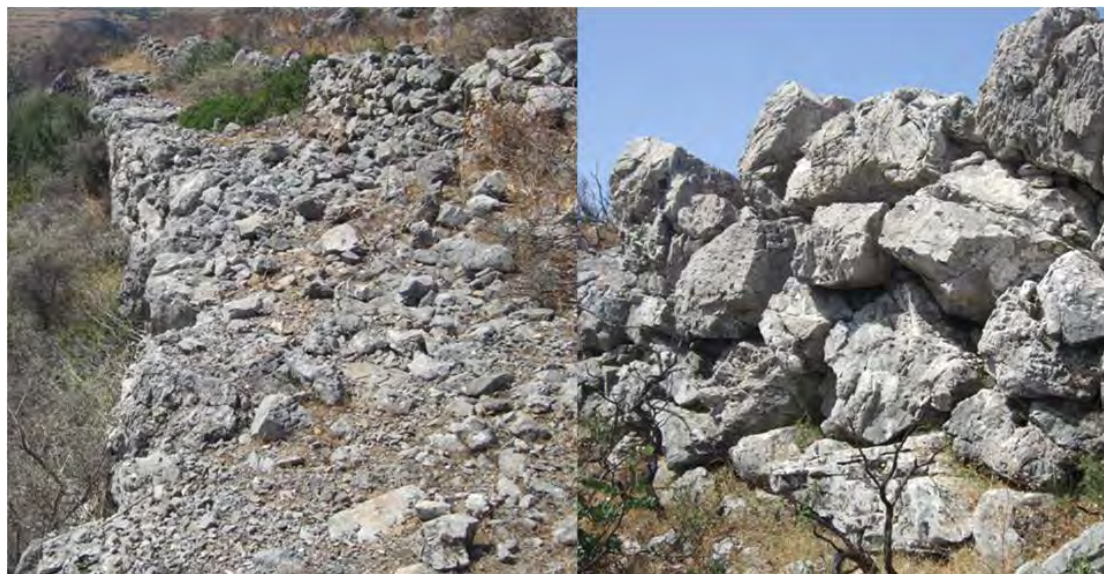
Εικ. 3. Άποψη του ανατολικού οχυρωματικού τείχους κατά μήκος από βόρεια (αριστερά), και άποψη της όψης του τείχους εξωτερικά (δεξιά) (φωτ. των συγγραφέων).
