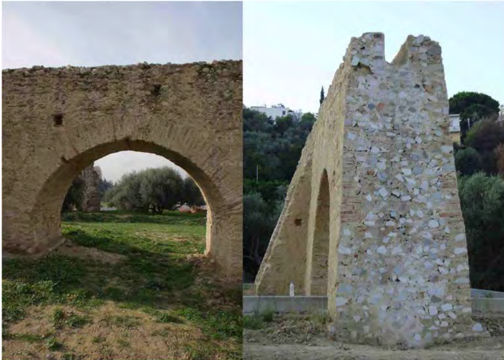
Εικ. 9. Μεσαιωνικό Υδραγωγείο. Καμάρα και η τοιχοποιία όπως εμφανίστηκε μετά από τη συρματοκοπή (Αρχείο ΕΦ.Α.ΑΧΑ.).
