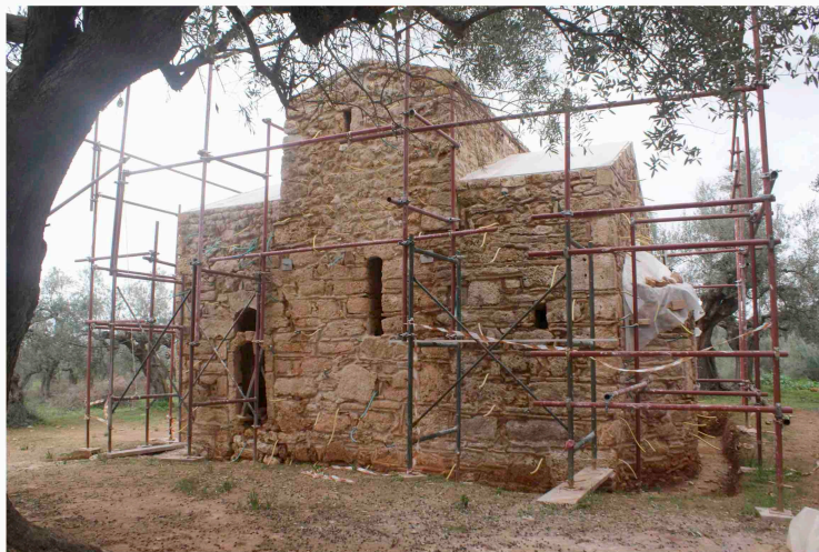
Εικ. 8. Αποκατάσταση ναού Ανάληψης Φιλιατρών (φωτ. ΕΦ.Α.ΜΕΣ.).
