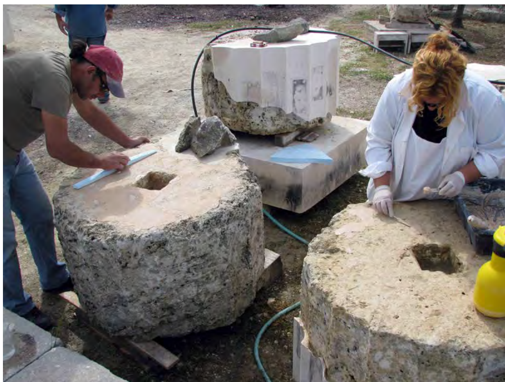
Εικ. 5. Εφαρμογή κονιάματος από τον μαρμαροτεχνίτη Π. Βαμβακά και την τεχνικό συντήρησης Μ. Λίτσα (φωτ. Γ. Αναστασιάδου).
