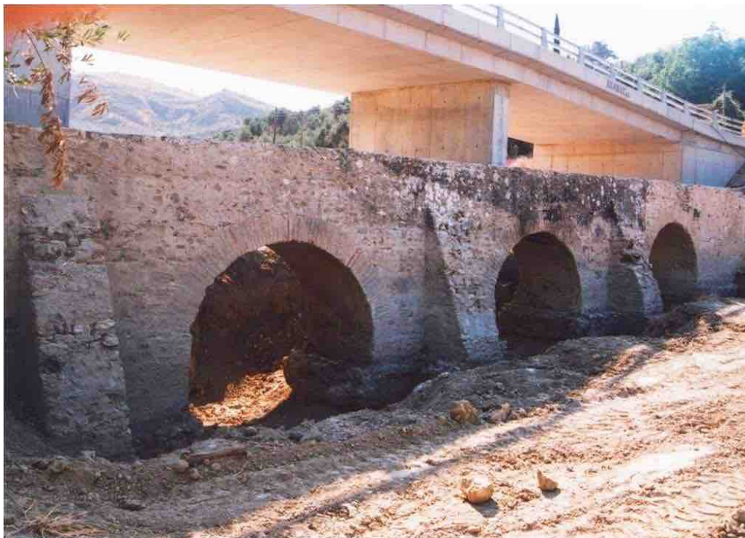
Εικ. 6. Το Μεσαιωνικό Υδραγωγείο Πάτρας και η σύγχρονη γέφυρα (Αρχείο ΕΦ.Α.ΑΧΑ.).
