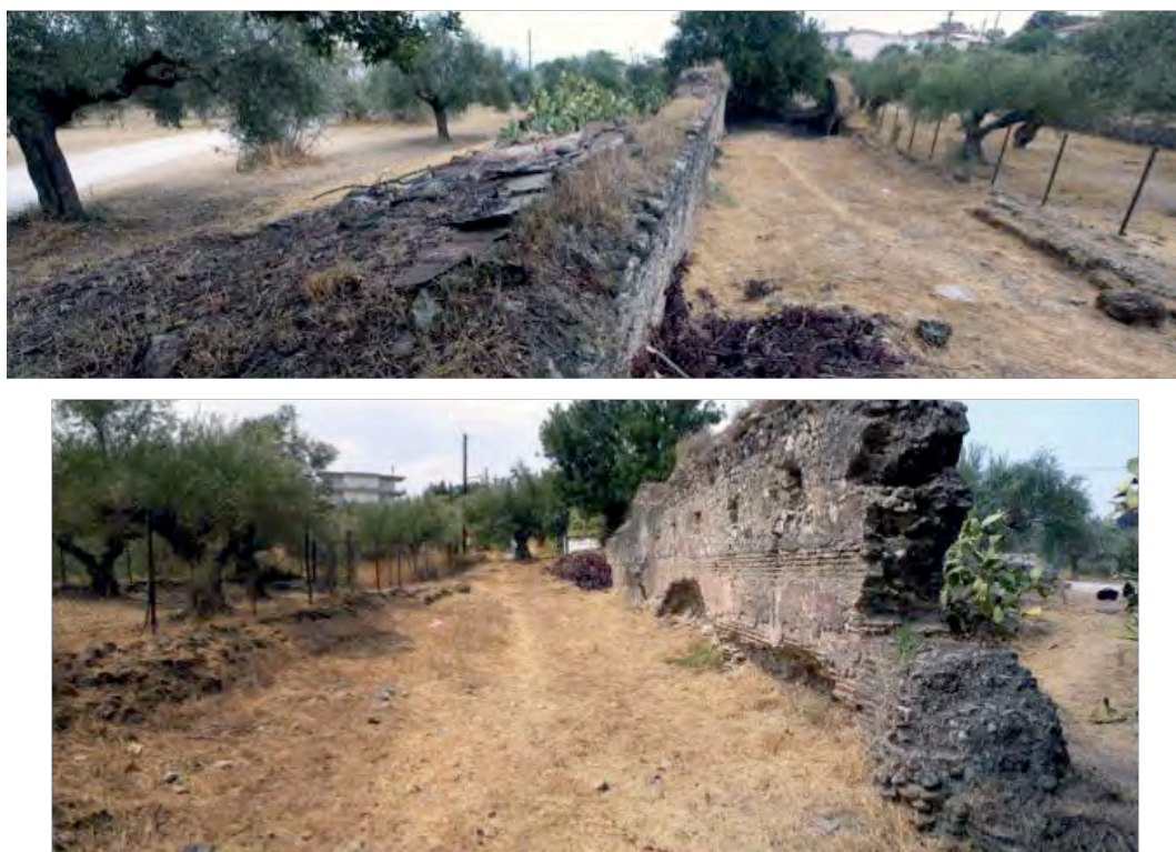
Εικ. 3. Γύθειο, θέση «Καμάρες Ανδρεάκου». Η δεξαμενή του υδραγωγείου (φωτ. των συγγραφέων).
