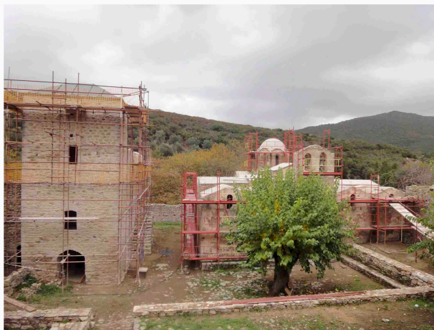
Εικ. 1. Αποκατάσταση της Μονής Μεταμόρφωσης του Σωτήρος (Ανδρομονάστηρο) (φωτ. ΕΦ.Α.ΜΕΣ.).
