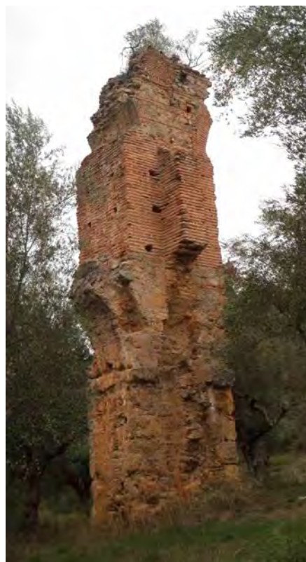
Εικ. 4. Υδραγωγείο Σπάρτης, θέση Πίττα Καραβά. Ο πεσσός της υδατογέφυρας (φωτ. των συγγραφέων).
