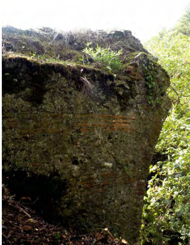
Εικ. 1. Υδραγωγείο Γυθείου, θέση «Στάρα». Πεσσός υδατογέφυρας (φωτ. των συγγραφέων).
