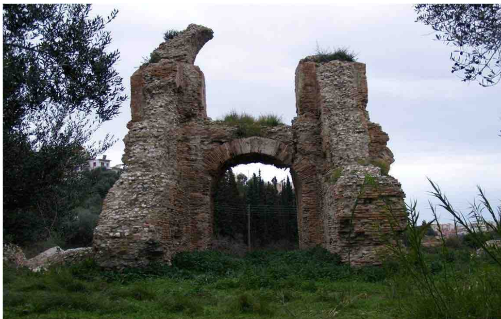
Εικ. 3. Το Ρωμαϊκό Υδραγωγείο. Το καλύτερα σωζόμενο τμήμα (Αρχείο ΕΦ.Α.ΑΧΑ.).
