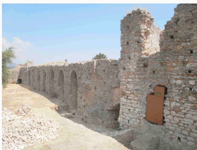
Εικ. 6. Αναστήλωση ανατολικού τμήματος τειχών κάστρου Ανδρούσας (φωτ. ΕΦ.Α.ΜΕΣ.).
