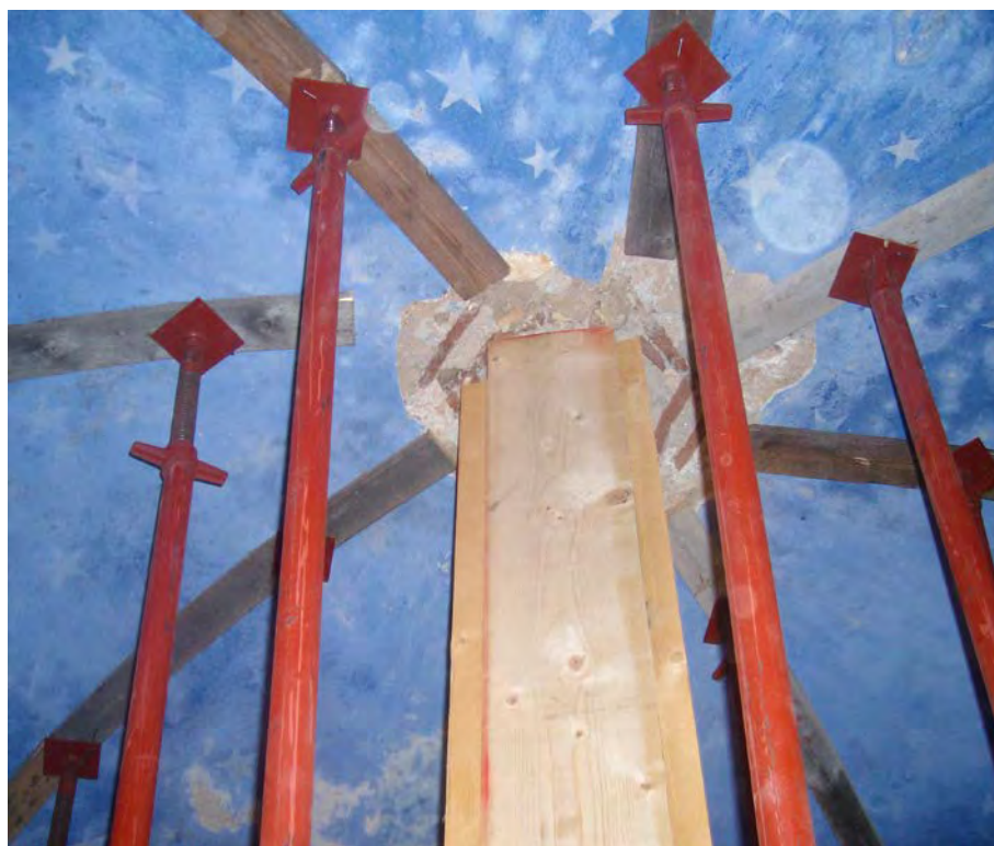
Εικ. 6. Υποστύλωση του κεντρικού τρούλου (φωτ. Μ.-Χ. Στάικου).
