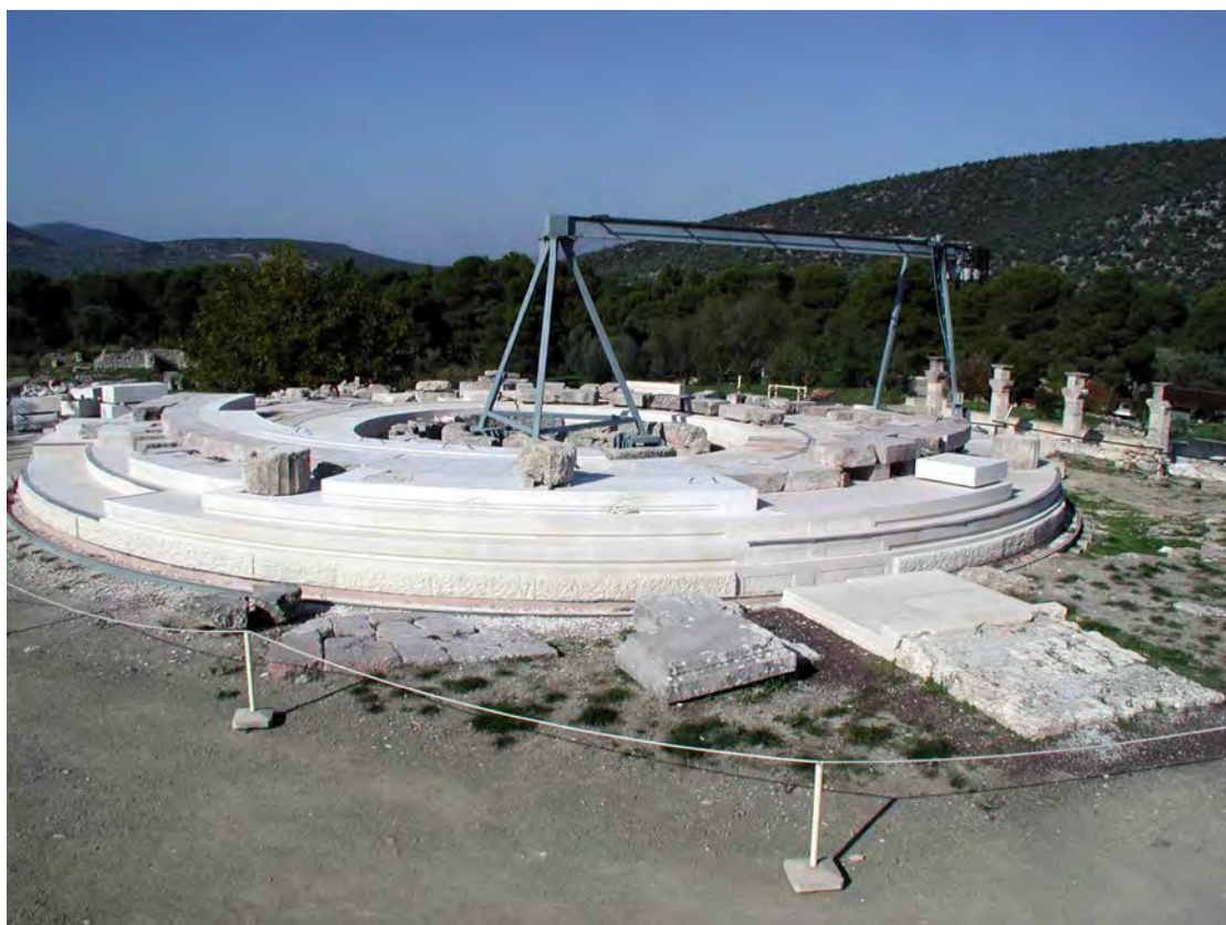
Εικ. 1. Εργασίες αποκατάστασης στην κρηλίδα του μνημείου (Αρχείο Ε.Σ.Μ.Ε., 2005).
