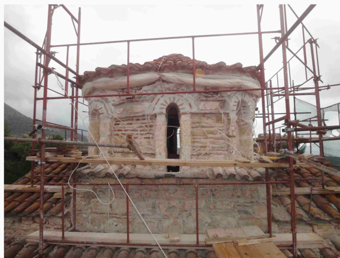
Εικ. 5. Αποκατάσταση του τρούλλου του ναού Αγίου Νικολάου στο Καμπινάρι Πλάτσας (φωτ. ΕΦ.Α.ΜΕΣ.).
