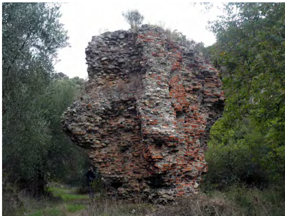
Εικ. 2. Υδραγωγείο Γυθείου, θέση «Κουτούπα». Πεσσός υδατογέφυρας (φωτ. των συγγραφέων).
