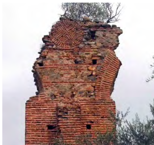
Εικ. 6. Υδραγωγείο Σπάρτης, θέση Πίττα Καραβά. Το ανώτερο τμήμα του πεσσού της υδατογέφυρας και ο κεραμοπλαστικός διάκοσμός του (φωτ. των συγγραφέων).
