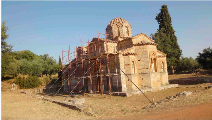
Εικ. 7. Οι εργασίες συντήρησης του ναού Ζωοδόχου Πηγής Σαμαρίνας (φωτ. ΕΦ.Α.ΜΕΣ.).
