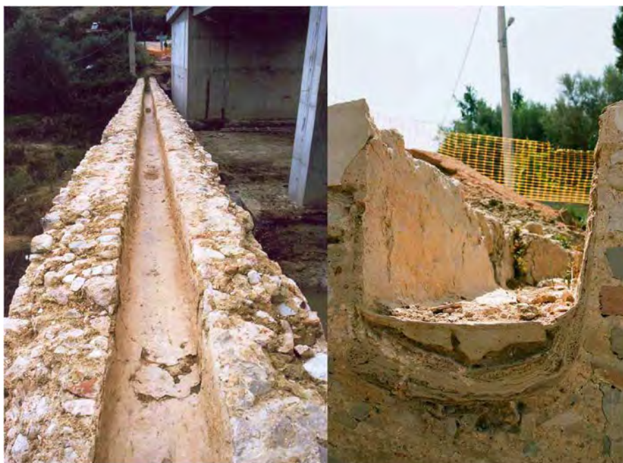
Εικ. 8. Μεσαιωνικό Υδραγωγείο. Ο υδραύλακας (Αρχείο ΕΦ.Α.ΑΧΑ.).
